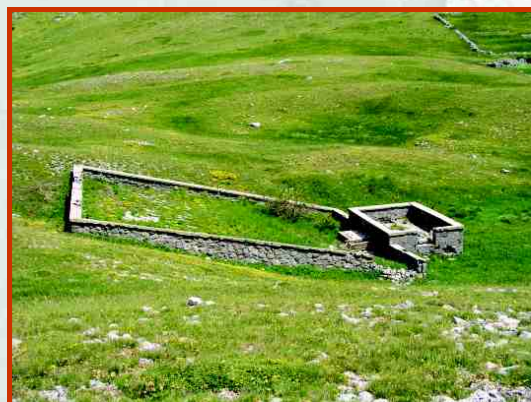
Zajednička šterna s velikom slivnom površinom za prikupljanje vode (vodolov).
